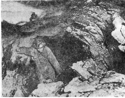
图 1 某金矿巷岩爆实况
